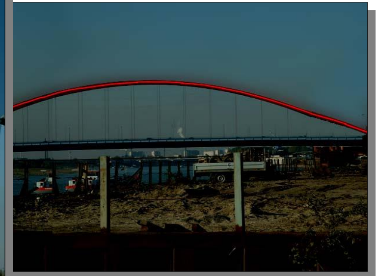
Brücke der Solidarität
